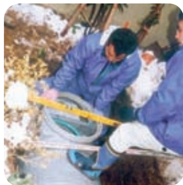
浄化槽も手堀で埋め込んだ。
