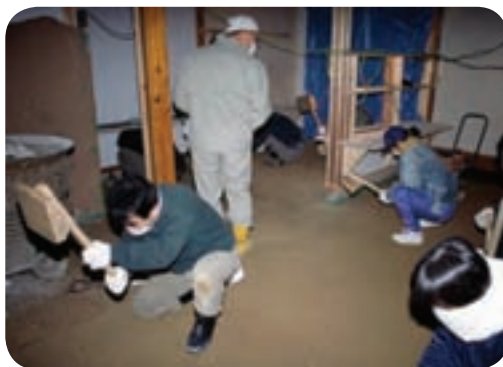
昔懐かしいような店舗にするために、全員で土間打ちを行う。
